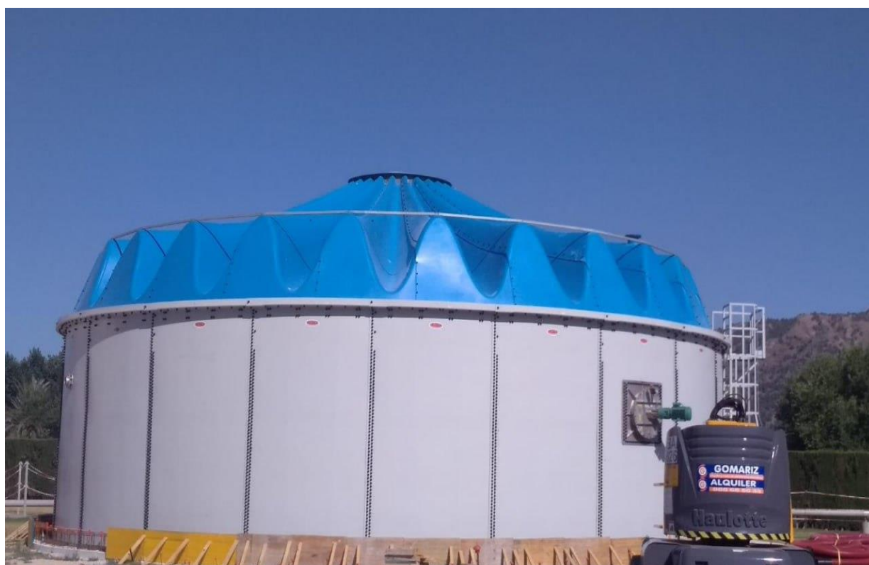
Рис. 2.8. Очисні споруди біологічної очистки.
