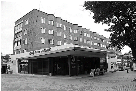
Рис. 9.5. Вбудовано-прибудована торговельна споруда
