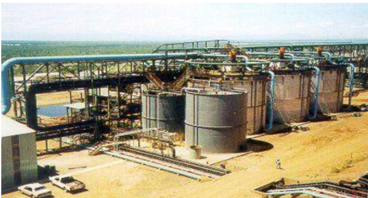
Рис. 2.2. Чанова установка для обробки золотоносних мінералів рудника Fairview (Південна Африка)
